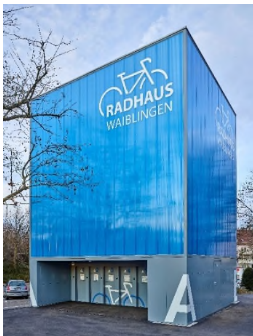
Abbildung 4: Radhaus gegenüber dem Bahnhof Waiblingen (Bild: Parkierungsgesellschaft Waiblingen GmbH)
