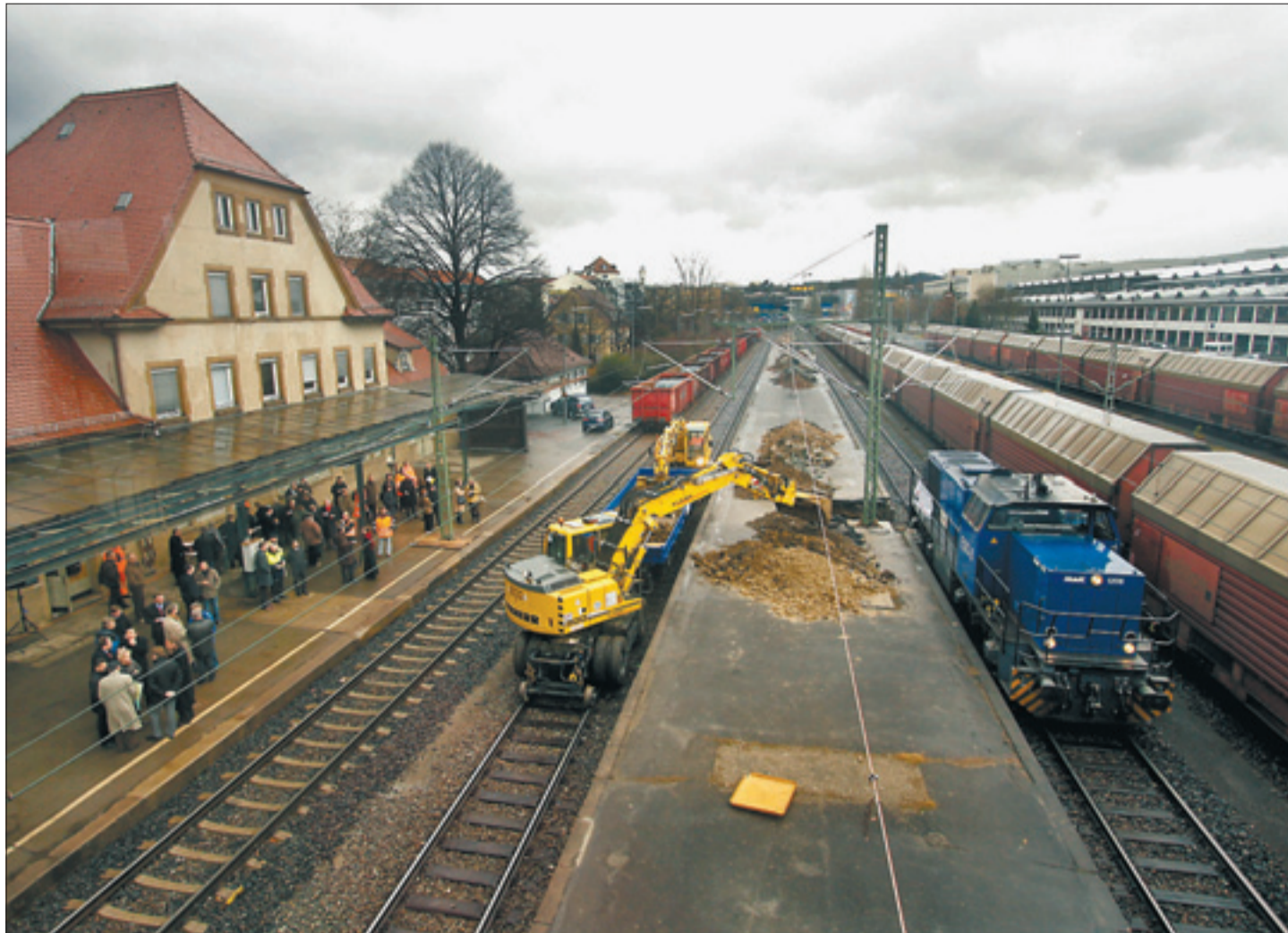
Die Bauarbeiten in Sindelfingen haben begonnen – die Sicherheitstechnik verursacht Mehrkosten in Höhe von drei Millionen Euro. Foto: factum/FA.
